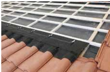
1 Unteren Anschluss und erste Bügelreihe vorbereiten.
