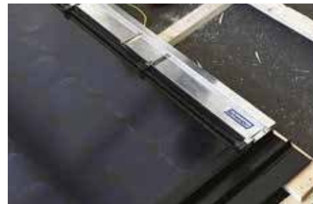
3 Nächste Bügelreihe mit Hilfe der Montagelehre anbringen.
